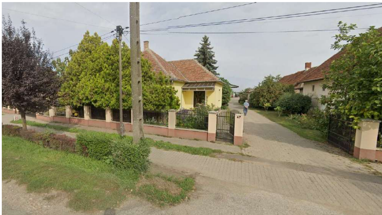
290 hrsz-ú ingatlan Forrás: Google street view
